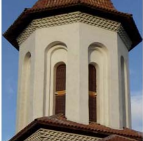
a, b : Vernești, Buzău, sec. al XiX-lea, turnul clopotniță reconstituit, pe structura ușoară
